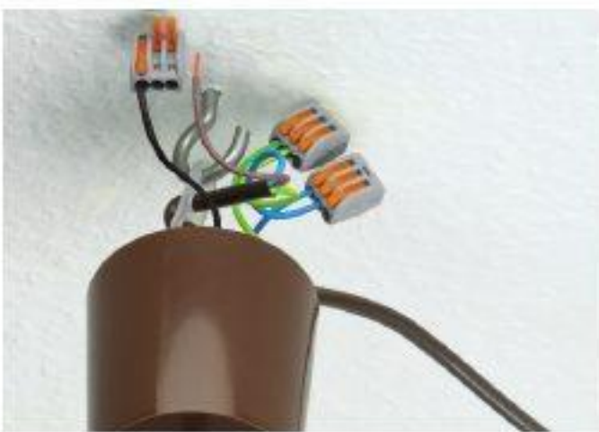
Conexión de elemento de iluminación con conductores flexibles y alimentación de corriente
